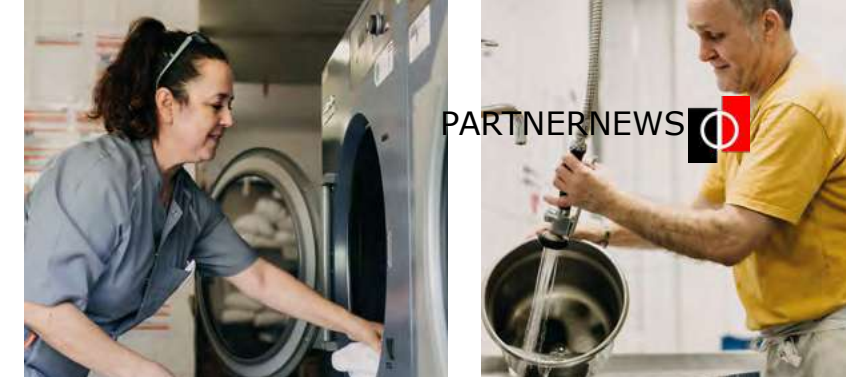
Zu den Energieverbrauchern des Hotels gehört die Wäscherei... und die Warmwasserbereitung (Fotos: Hotel Drei Quellen Therme)
